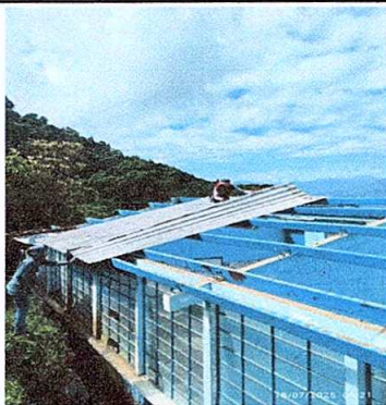
Foto 1: CUBIERTA DE LAMINAS
