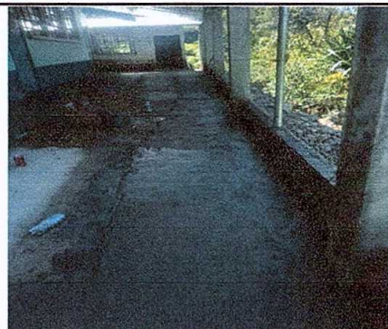
Foto 6: PISO DETERIORADO
