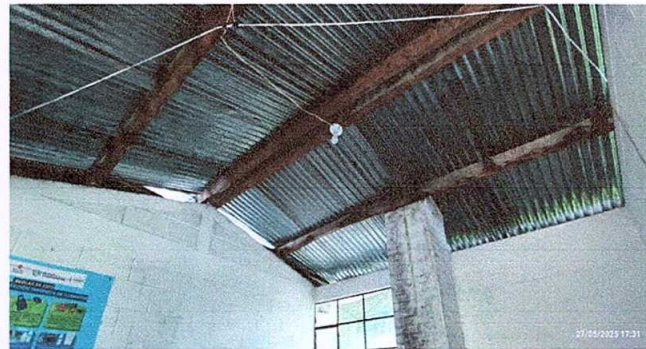
Foto 2: ESTRUCTURA DE TECHO
