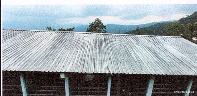
Foto1: CUBIERTA DE LAMINAS
