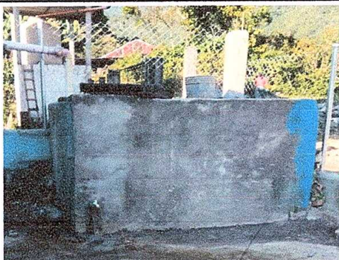
Foto 3: Repello de tanque
