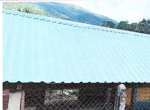
Foto 4: Cambio de láminas
