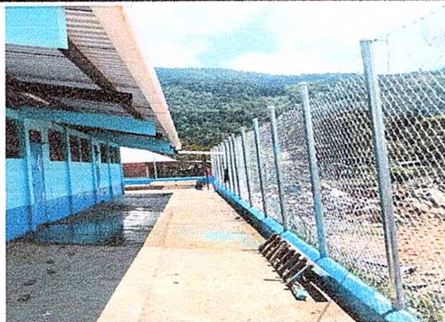
Foto 5: Cambio de malla galvanizada
