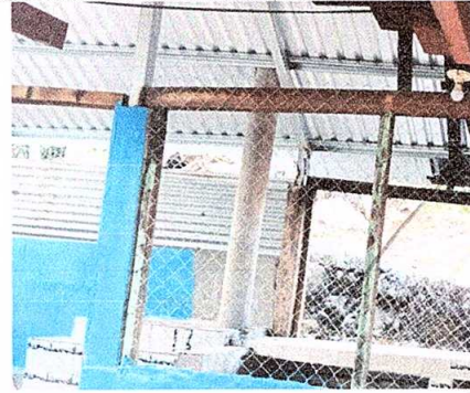
Foto 6: Sustitución de estructura de madera por metal
