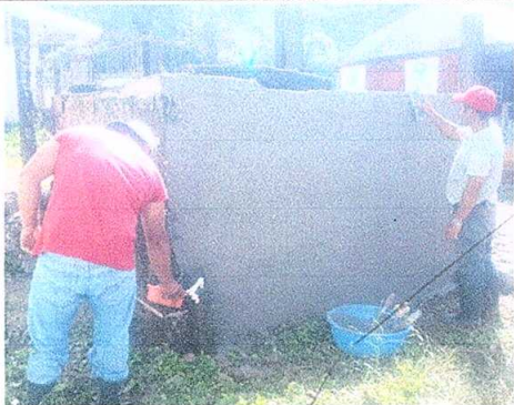
Foto 3: Repello de tanque
