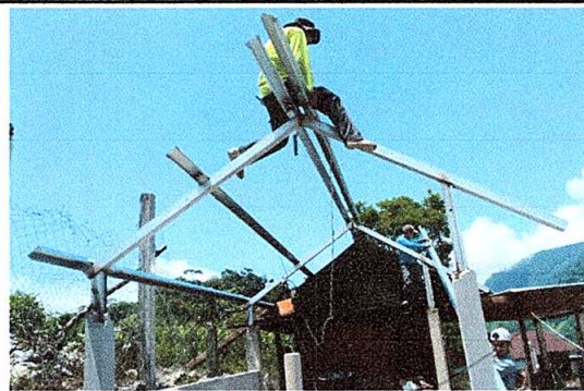
Foto 6: Sustitución de estructura de madera por metal
