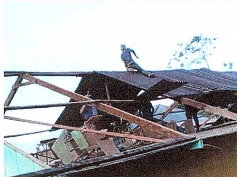
Foto 4: Cambio de láminas
