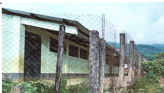
Foto 5: Cambio de malla galvanizada
