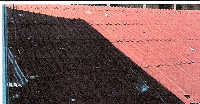
Foto 4: Cambio de laminas
