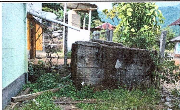
Foto 3: repello de tanque
