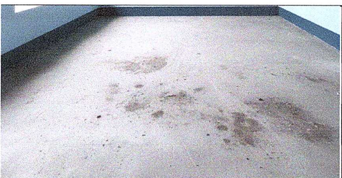
Foto 5: Sustitución de piso de torta de concreto
