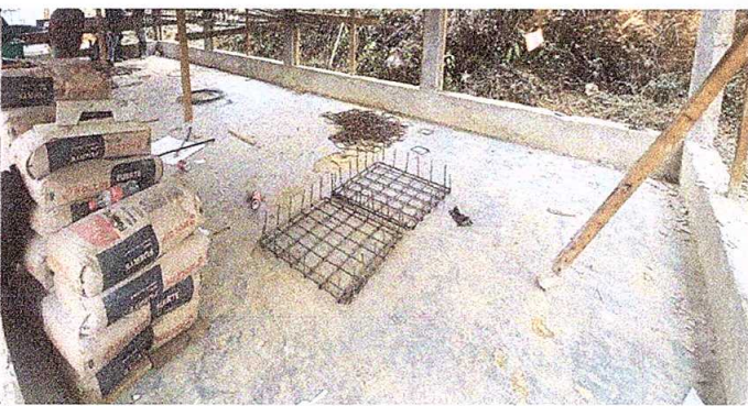
Foto 5: Sustitución de piso de torta de concreto
