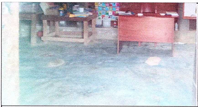
Foto 5: Sustitución de piso de torta de concreto
