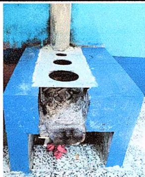
Foto 11: Sustitución de plancha de metal de 3 hornillas
