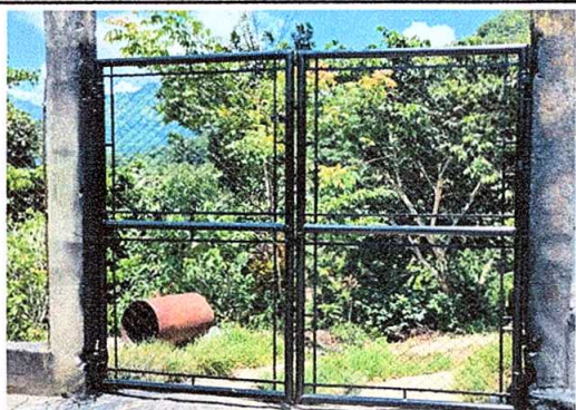
Foto 9: Mantenimiento a portones de metal de 3 metros x 2 metros
