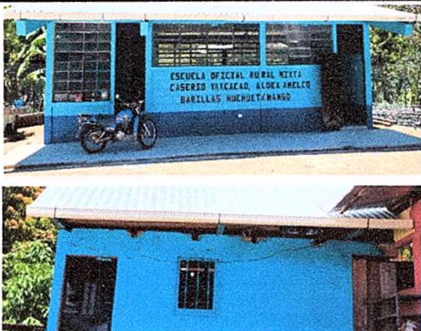
Foto 7: Pintura en muros interiores y exteriores
