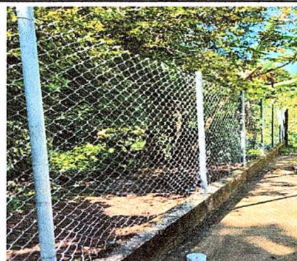
Foto 10: Reparación de tubo hg y malla galvanizada
