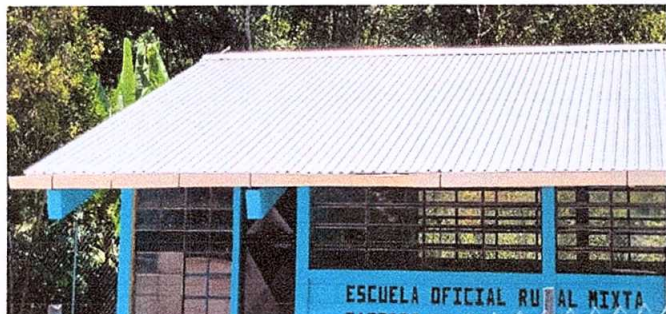
Foto 1: Sustrucción de lámina, por lámina troquelada aluzinc calibre 26
