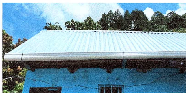
Foto 6: Sustrucción de canal de pvc, soporte o pescante de metal para canal y bajada de agua pluvial
