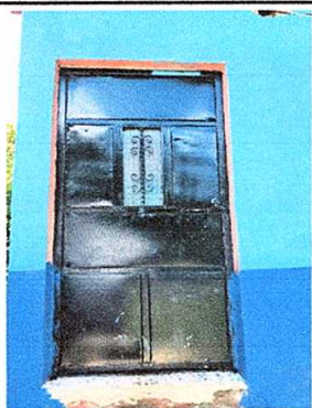
Foto 3: Mantenimiento de estructura de puerta (lijado, cambio de tubo, sujetones y aplicación de pintura) de 1 metro x 2 metros
