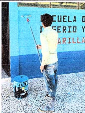
Foto 7: Pintura en muros interiores y exteriores
