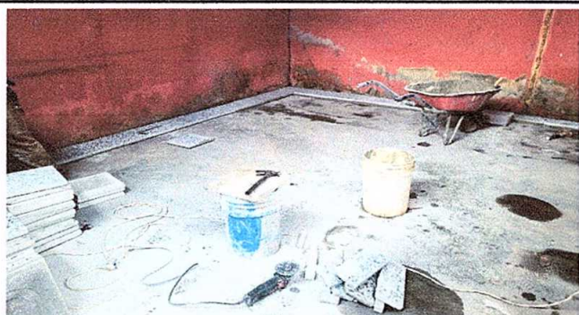
Foto 5: Sustrucción de piso de granito
