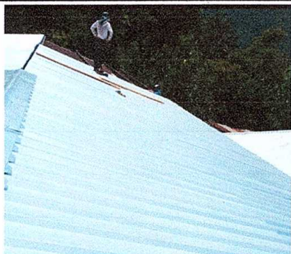
Foto 1: Sustrucción de lámina, por lámina troquelada aluzinc calibre 26
