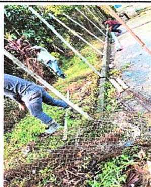
Foto 10: Reparación de tubo hg y malla galvanizada
