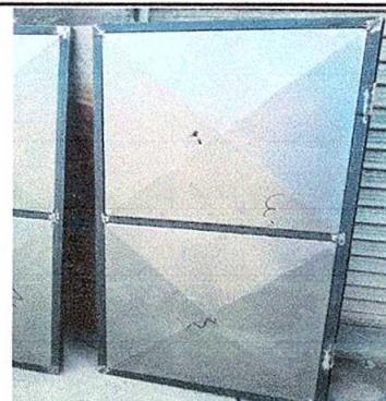
Foto 4: Sustrucción de puerta en sanitarios de metal por metal 1.50 metros x 0.80 metros
