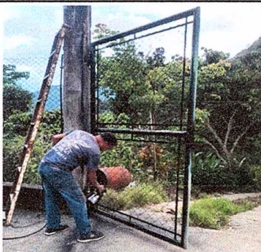
Foto 9: Mantenimiento a portones de metal de 3 metros x 2 metros
