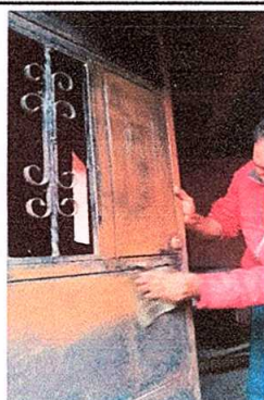
Foto 3: Mantenimiento de estructura de puerta (lijado, cambio de tubo, sujetones y aplicación de pintura) de 1 metro x 2 metros
