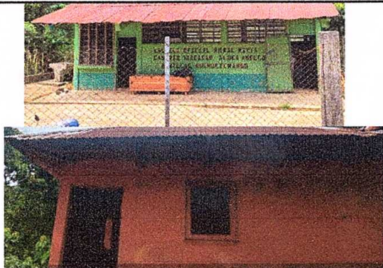
Foto 7: Pintura en muros interiores y exteriores
