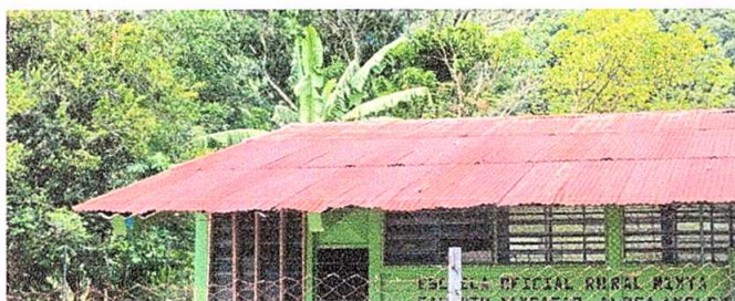
Foto 1: Sustitución de lámina, por lámina troquelada aluzinc calibre 26
