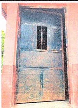
Foto 3: Mantenimiento de estructura de puerta (lijado, cambio de tubo, sujetones y aplicación de pintura) de 1 metro x 2 metros
