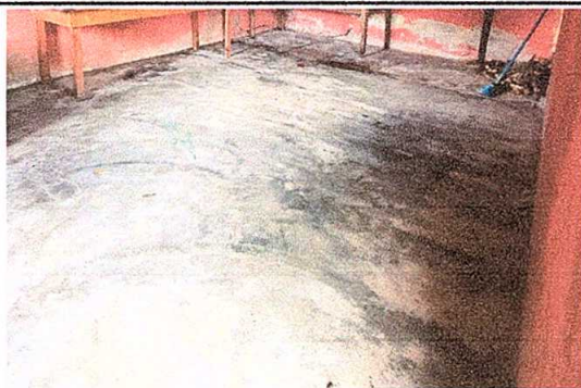
Foto 5: Sustitución de piso de granito
