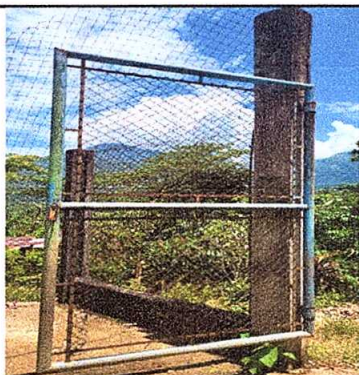
Foto 9: Mantenimiento a portones de metal de 3 metros x 2 metros
