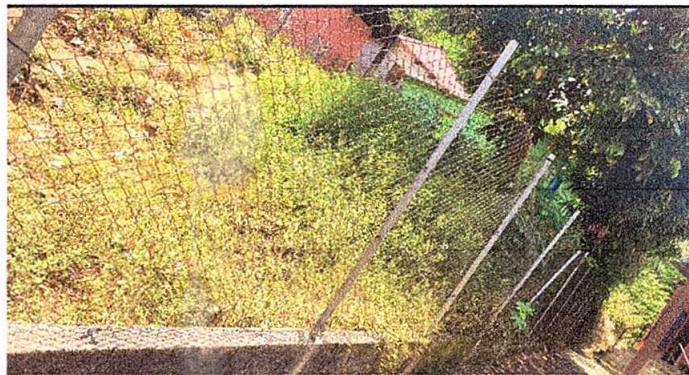
Foto 10: Reparación de tubo hg y malla galvanizada
