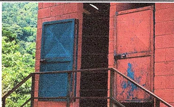
Foto 4: Sustitución de puerta en sanitarios de metal por metal 1.50 metros x 0.80 metros
