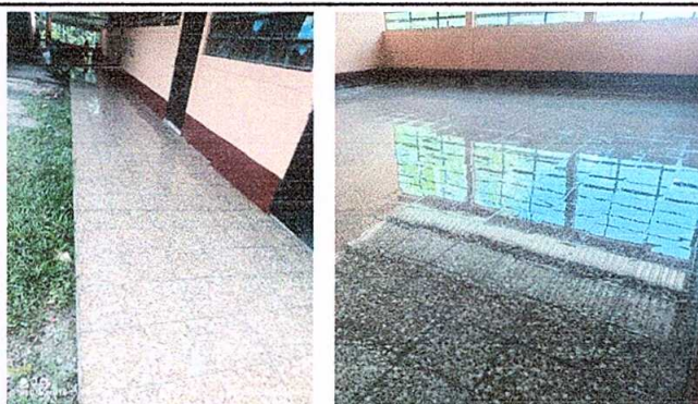
Foto 4: Sustitución de piso de granito del patio y de aulas
