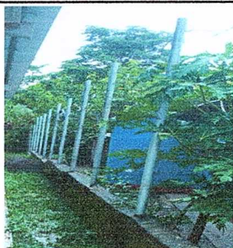
Foto 5: Reparación de tubo hg y malla galvanizada
