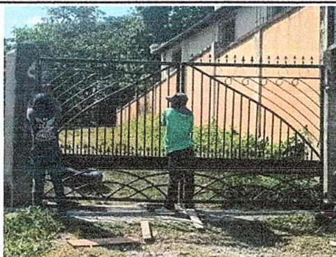
Foto 3: Sustitución de portón de metal de 3.94 metros x 2 metros
