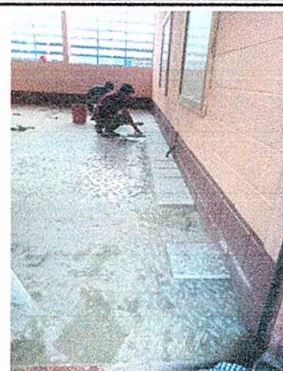
Foto 4: Sustitución de piso de granito del patio y de aulas
