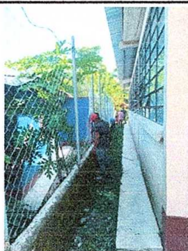
Foto 5: Reparación de tubo hg y malla galvanizada
