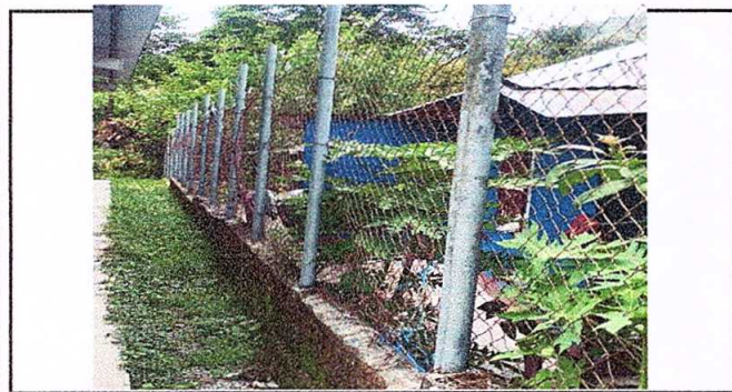
Foto 5: Reparación de tubo hg y malla galvanizada
