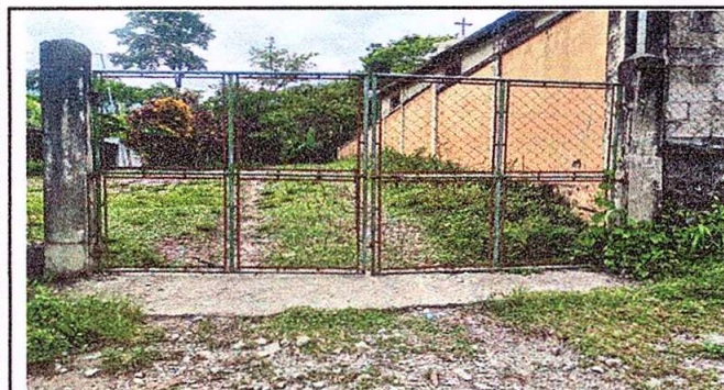
Foto 3: Sustrucción de portón de metal de 3.94 metros x 2 metros
