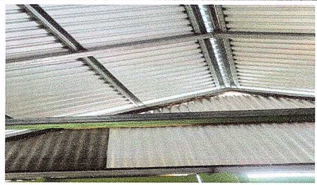
Foto 2: ESTRUCTURA DE TECHO
