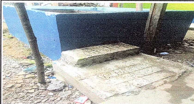
Foto 10: REPARACION Y MANTENIMIENTO DE CISTERNAS/DEPÓSITOS DE AGUA
