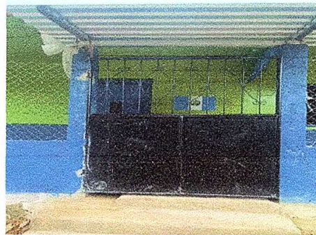
Foto 8: MANTENIMIENTO A PORTONES
