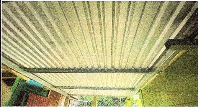
Foto1: CUBIERTA DE LÁMINA
