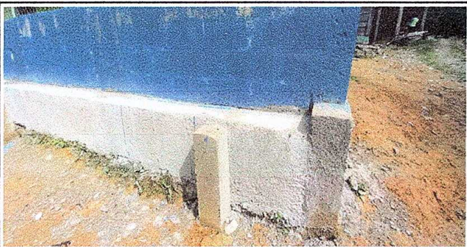
Foto5: CUNETETA DE CONCRETO
