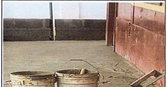
Foto 4: PISO: SUSTITUCIÓN DE PISO DE CONCRETO
