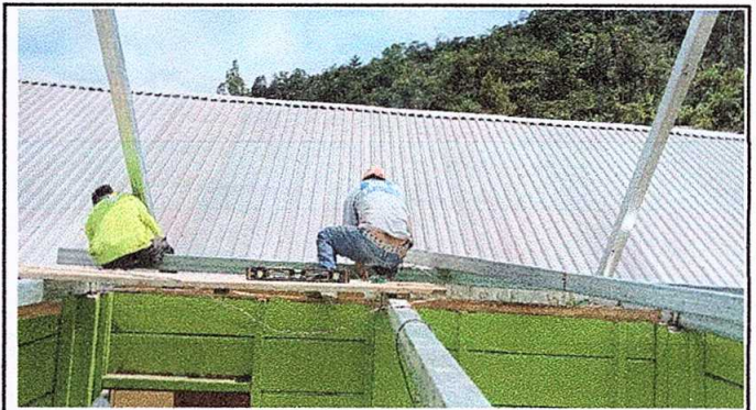
Foto 2: ESTRUCTURA DE TECHO
