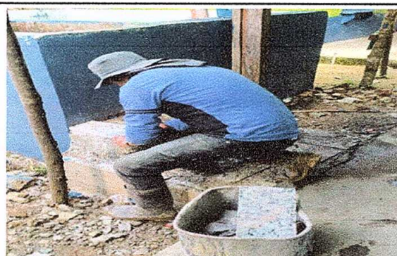
Foto 10: REPARACION Y MANTENIMIENTO DE CISTERNAS/DEPÓSITOS DE AGUA
