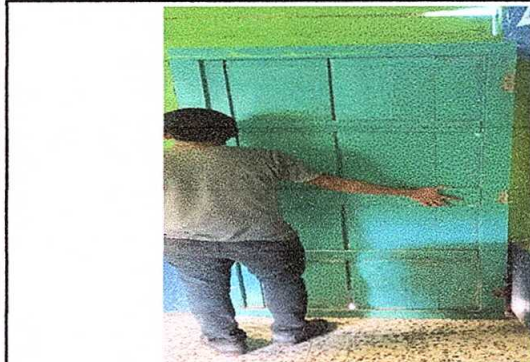
Foto 3: PUERTAS DE METAL
