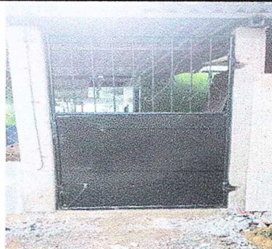
Foto 8: MANTENIMIENTO A PORTONES
