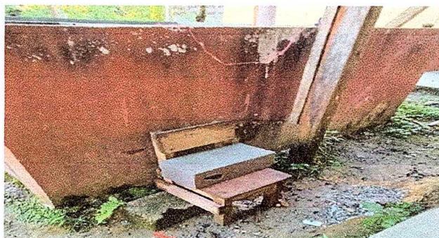
Foto 10: REPARACION Y MANTENIMIENTO DE CISTERNAS/DEPÓSITOS DE AGUA
