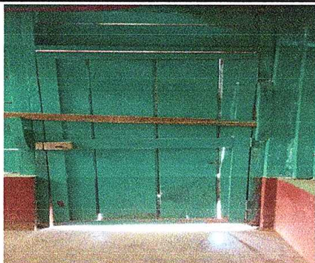
Foto 3: PUERTAS DE METAL
