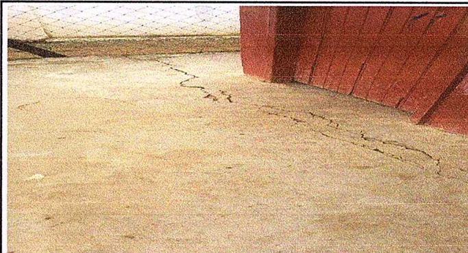
Foto 4: PISO: SUSTITUCIÓN DE PISO DE CONCRETO
