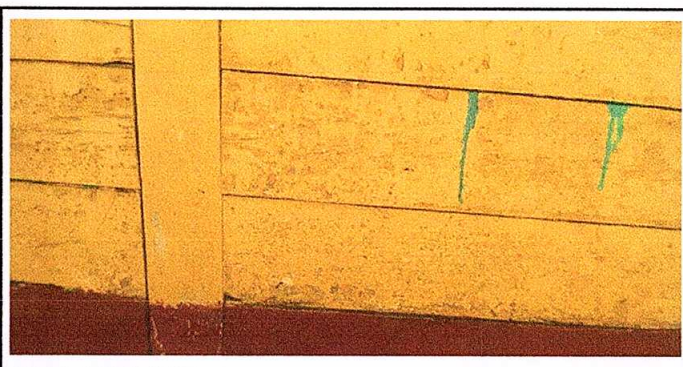
FOTO 6: PINTURA EN MUROS EXTERIORES E INTERIORES
