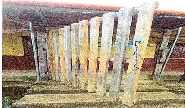
Foto 8: MANTENIMIENTO A PORTONES
