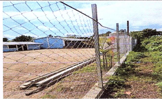
Foto 4: Reparación de muro perimetral
