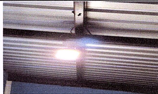
Foto 6: reparación del sistema eléctrico
