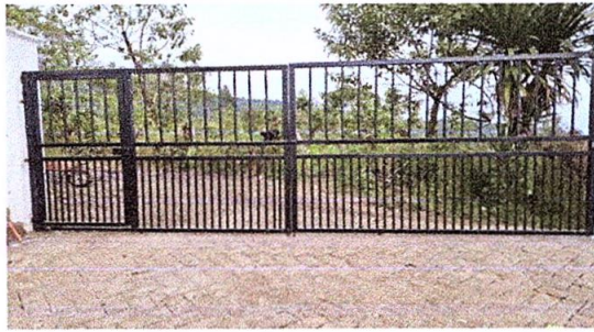
Foto 1: Mantenimiento a portones
