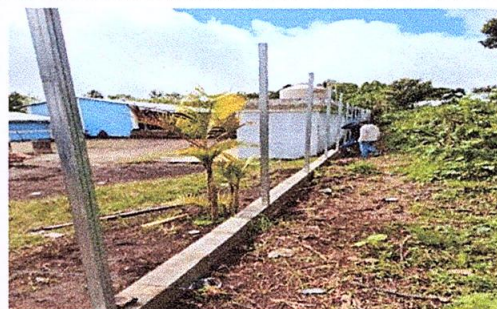
Foto 4: Reparación de muro perimetral
