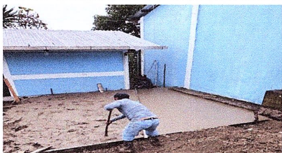
Foto 3: Reparación de pisos
