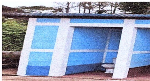
Foto 5: Sustitución de puertas en servicio sanitario
