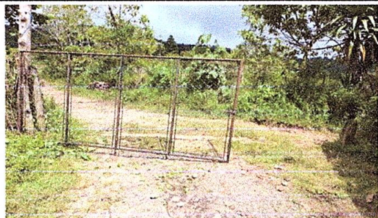
Foto 1: Mantenimiento a portones
