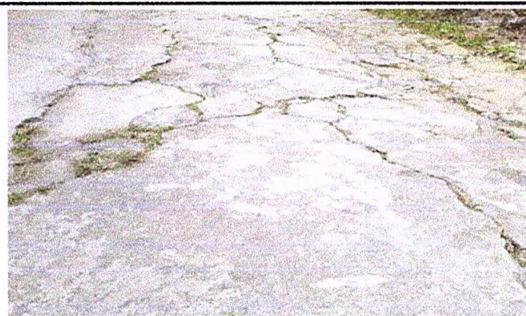
Foto 3: Reparación de pisos
