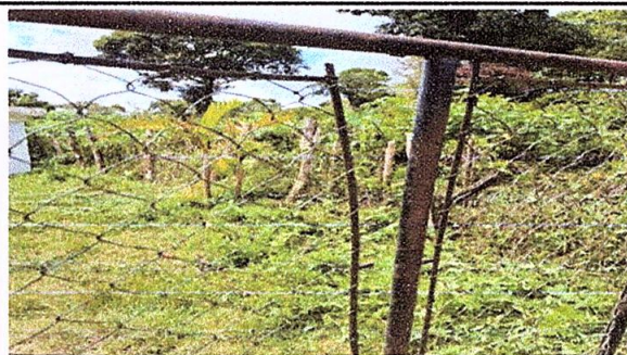
Foto 4: Reparación de muro perimetral
