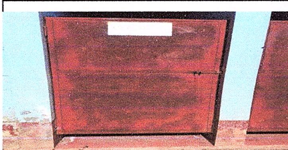
Foto 5: Sustitución de puertas en servicio sanitario
