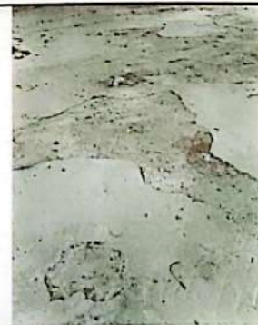
Foto 6: Sustitución de torta de cemento por piso de granito.
