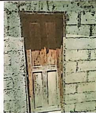
Foto 4: Sustitución de puerta de 1.00 x 2.20 mts con chapa de metal Yale.
