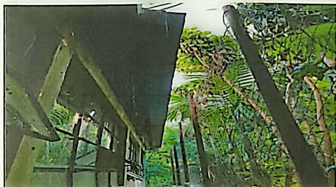
Foto 3: Sustrucción de canal de metal
