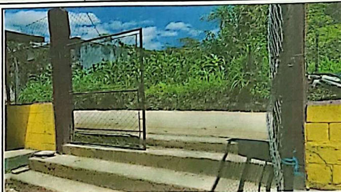
Foto 2: Sustrucción de portón de metal
