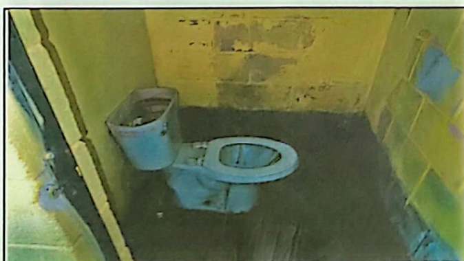
Foto 6: Sustrucción de inodoros
