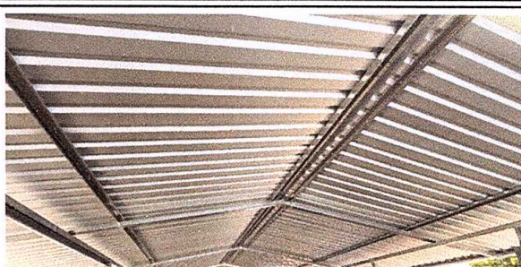
Foto 2: ESTRUCTURA INTERNA DE COCINA Y TECHO INTERIOR
