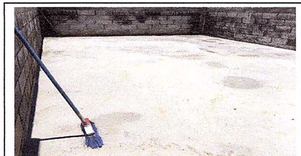
Foto 5: PISO DE CONCRETO
