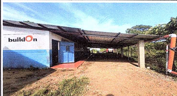
Foto 4: ENTECHADO DE PATIO MAS SOPORTE DE METAL Y BAJADA DE AGUA PLUVIAL.
