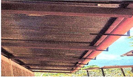
Foto1: SOPORTE DE METAL Y BAJADA DE AGUA PLUVIAL
