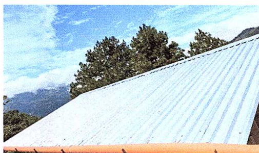
Foto 4: TECHO EXTERIOR DE COCINA
