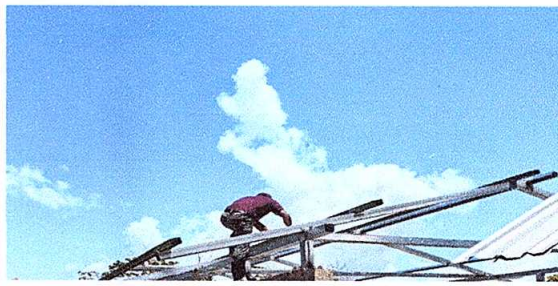
Foto 4: INSTALACION TECHO EXTERIOR DE COCINA
