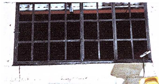
Foto 3: INSTALACION DE VENTANA DE COCINA
