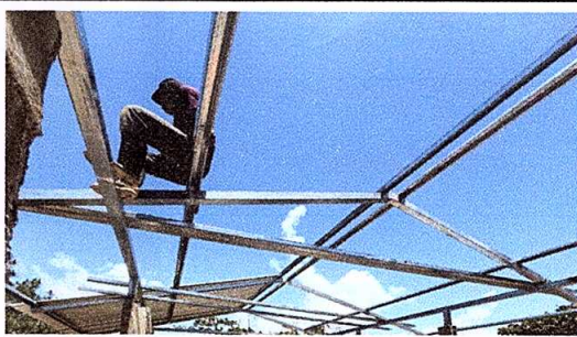
Foto 2: INSTALACION DE ESTRUCTURA INTERNA DE COCINA Y TECHO INTERIOR
