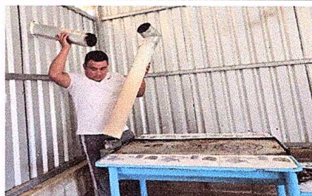
Foto 6: INSTALACION PLANCHA DE COCINA
