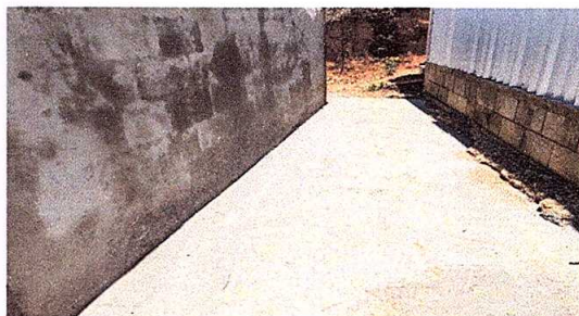
Foto 2: INSTALACION DE PISO PARA SOPORTE DE TINACO
