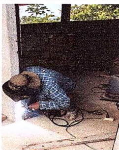
Foto1: INSTALACION PUERTA DE COCINA
