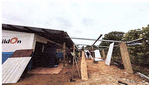
Foto 4: INSTALACION DE ENTECHADO DE PATIO
