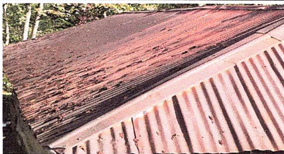
Foto 4: TECHO EXTERIOR DE COCINA
