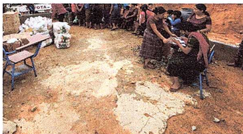
Foto 5: Sustitución de piso
