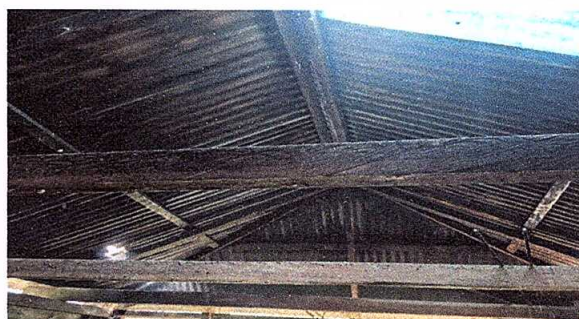
Foto 2: ESTRUCTURA INTERNA DE COCINA Y TECHO INTERIOR
