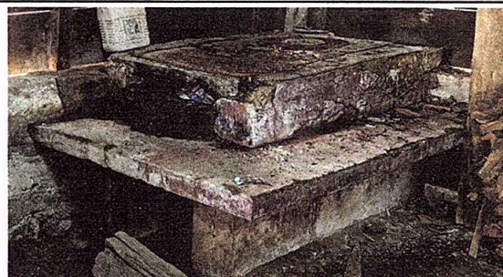
Foto 6: PLANCHA DETERIORADA DE COCINA
