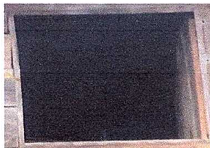
Foto 3: VENTANA DE COCINA
