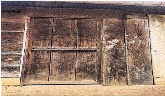
Foto 1: PUERTA DE COCINA
