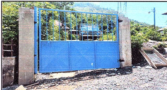
Foto 4: sustitución de portón de metal ( 2m de alto X 2m de ancho)
