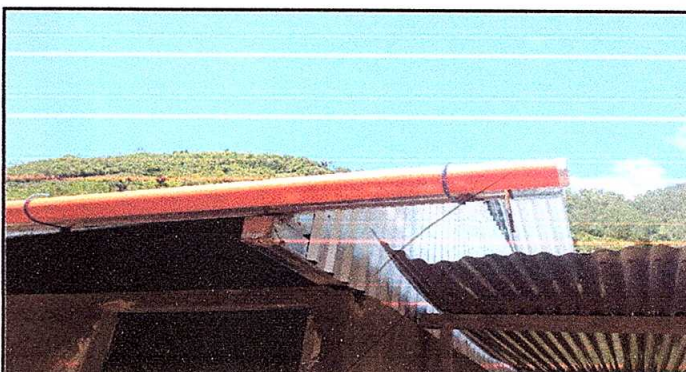
Foto 4: sustitución de canal de pvc
