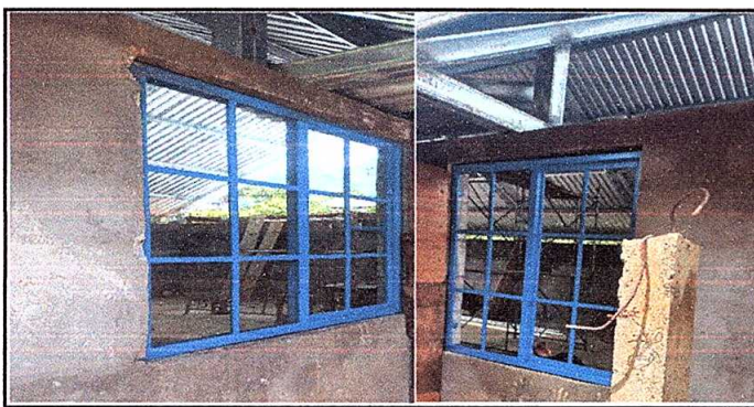
Foto 5: sustitución de 4 ventanas de madera por metal mas vidrio (1m de alto X 1m de ancho)
