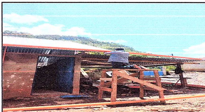
Foto 4: sustitución de canal de pvc
