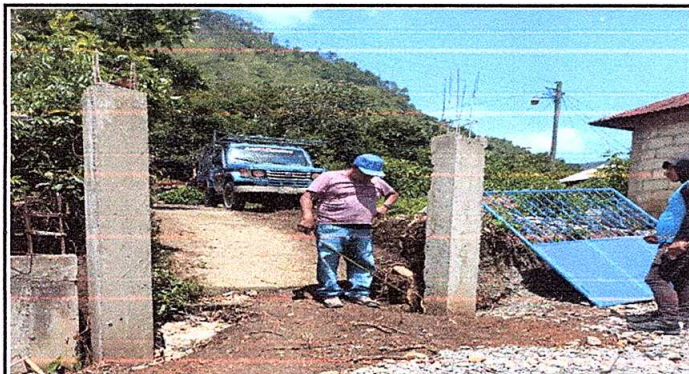
Foto 3: sustitución de portón de metal (2m de alto X 2m de ancho)
