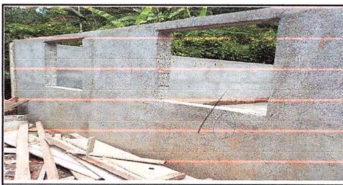
Foto 6: sustitución de ventanas de madera por metal mas vidrio (1m de alto X 1m de ancho)
