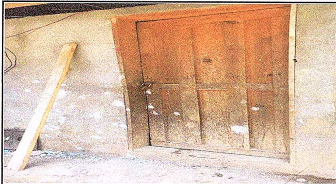
Foto 1: sustitución de puerta (2.10m de alto X 1.00m de ancho)
