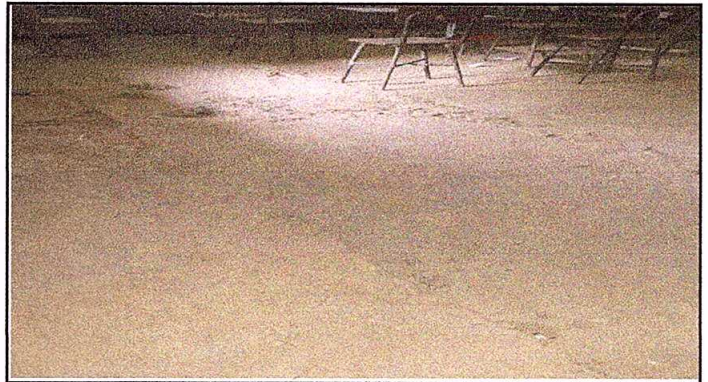
Foto 2: sustitución de piso de cemento líquido
