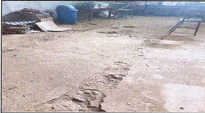
Foto 1: sustitución de piso de cemento líquido
