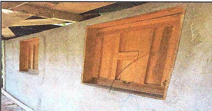
Foto 6: sustitución de ventanas de madera por metal mas vidrio (1m de alto X 1m de ancho)
