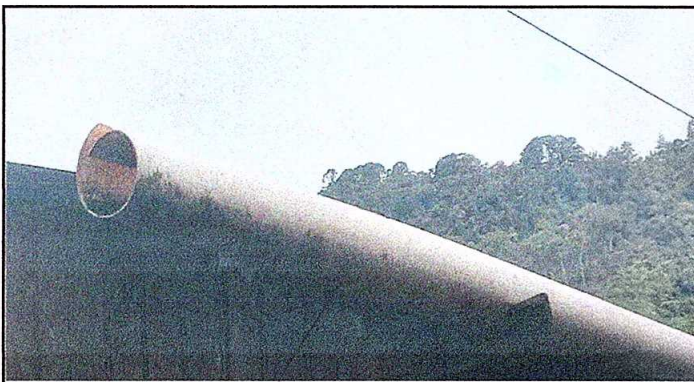
Foto 3: sustitución de canal de pvc
