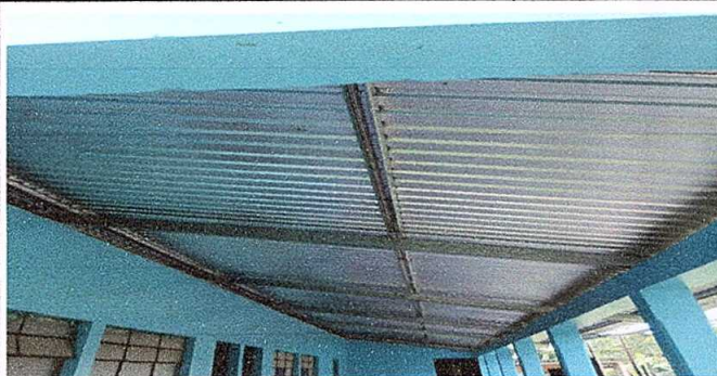
Foto 3: ESTRUCTURA DE SOPORTE DE METAL
