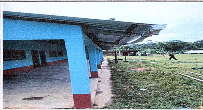
Foto 2: CANALES Y BAJADAS DE AGUA PLUVIAL
