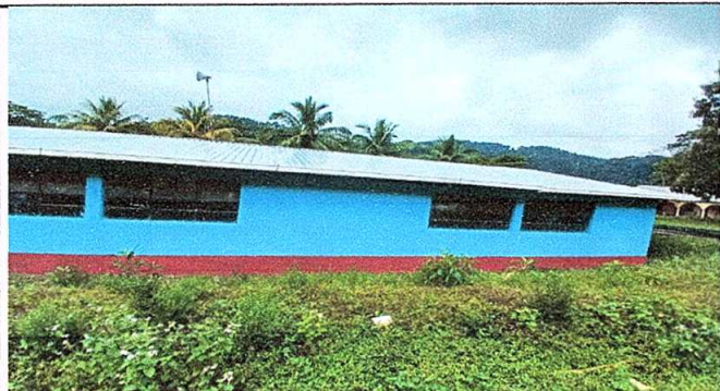
Foto 1: SUSTITUCIÓN DE LÁMINA A LÁMINA TROQUELADA ALUZINK CALIBRE 26
