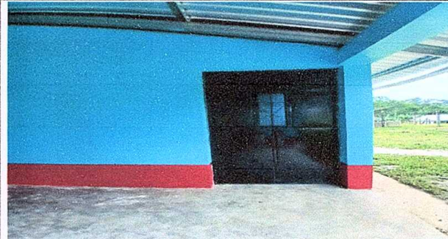
Foto 4: PUERTA DE METAL
