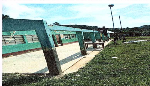
Foto 2: SUSTITUCION DE BAJADAS DE AGUA
