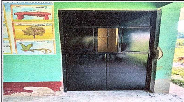
Foto 4: PUERTA DE METAL
