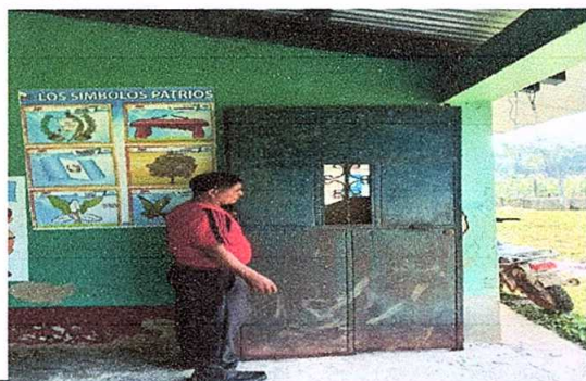
Foto 5: LIJADO DE PUERTA Y PINTURA
