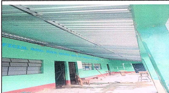
Foto 3: SUSTITUCION DE SOPORTE DE MADERA A METAL
