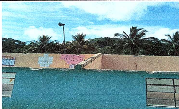
Foto 1: SUSTITUCION DE LAMINA TROQUELADA ALUZINK CALIBRE 26
