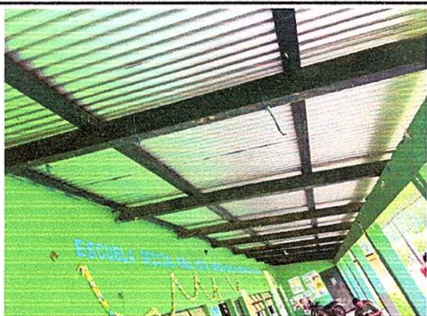
Foto 3: Sustrucción de estructura de soporte de madera, por metal
