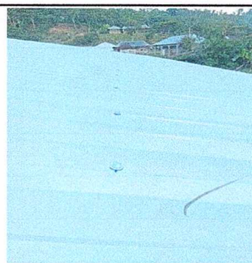
Foto 4: Sustitución de elementos de fijación
