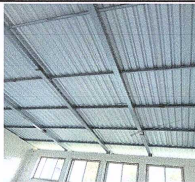
Foto 6: Sustitución de estructura de soporte de madera, por metal
