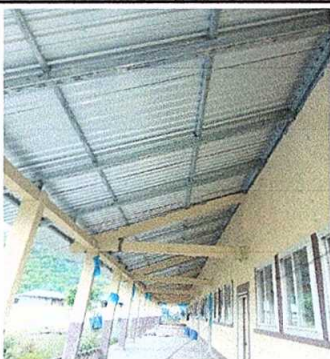
Foto 5: Sustitución de estructura de soporte de madera, por metal
