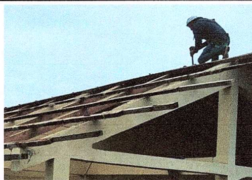
Foto 3: Sustitución de capote de lámina para lámina troquelada
