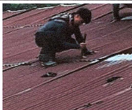
Foto 4: Sustitución de elementos de fijación
