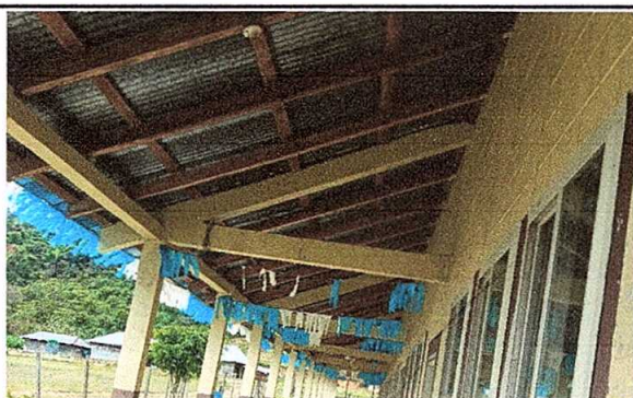
Foto 5: Sustitución de estructura de soporte de madera, por metal
