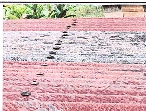
Foto 4: Sustitución de elementos de fijación
