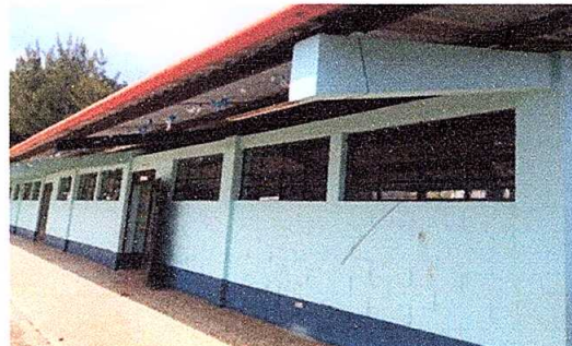
Foto 4: pintura en muros exteriores e interiores.
