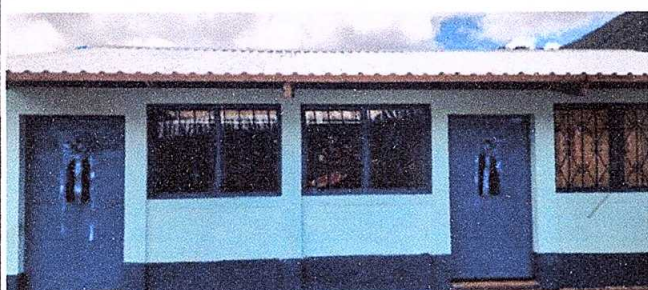
Foto 3: Sustitución de ventanas de madera por metal mas vidrio y mantenimiento de balcones.
