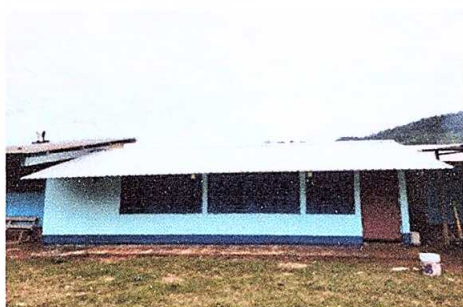
Foto 1: Sustitución de lámina, por lámina troquelada aluzinc calibre 26, sustitución de capote de lámina para lámina troquelada y sititución de elementos de fijación.
