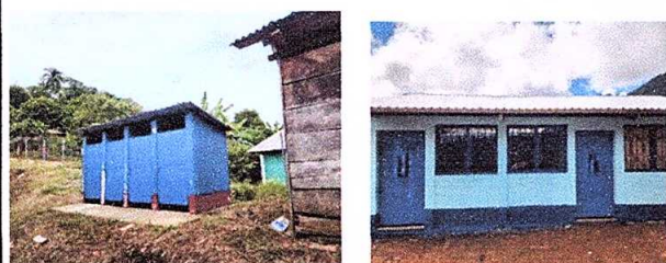
Foto 5: Sustitución de puertas de metal 2.10 mts de lato por 1 mts. De ancho y sustitución de puertas en servicios sanitarios, 1.63 metros de alto por 84 Cms. De ancho.
