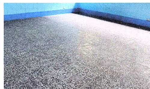
Foto 6: sustitución de piso de granito.
