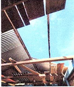
Foto 1: Sustrucción de lámina, por lámina troquelada aluzinc calibre 26, sustrucción de capote de lámina para lámina troquelada y sititución de elementos de fijación.
