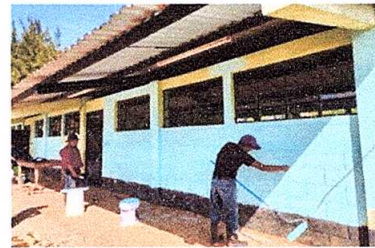
Foto 4: pintura en muros exteriores e interiores.
