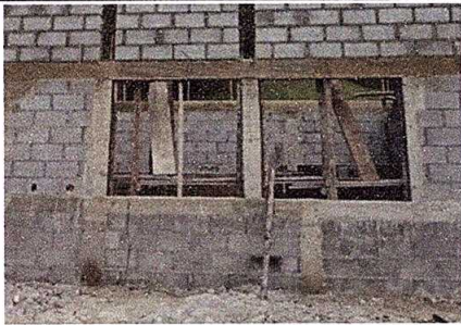
Foto 3: Sustrucción de ventanas de madera por metal mas vidrio y mantenimiento de balcones.
