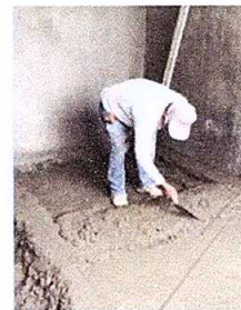
Foto 6: sustrucción de piso de granito.
