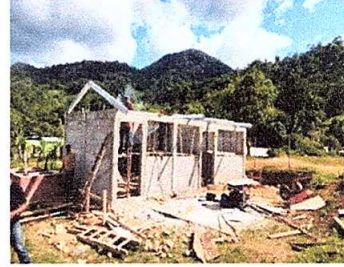
Foto 2: sustrucción de estructura de soporte de madera, por metal.
