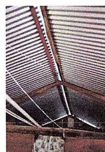
Foto 2: Sustitución de estructura de soporte de madera, por metal
