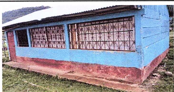
Foto 3: Sustitución de ventanas de madera por metal mas vidrio y Mantenimiento a balcones de metal.
