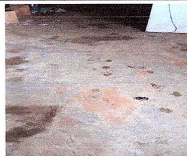
Foto 6: Sustitución de piso de granito
