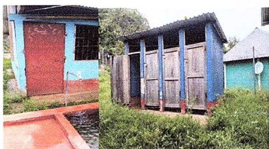
Foto 5: Sustitución de puerta de metal 2.10 mts de alto por 1 mts de ancho y Sustitución de puertas en servicios sanitarios, 1.63 metros de alto por 84 cms de ancho.
