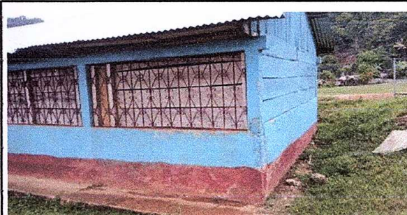
Foto 4: Pintura en muros exteriores e interiores.
