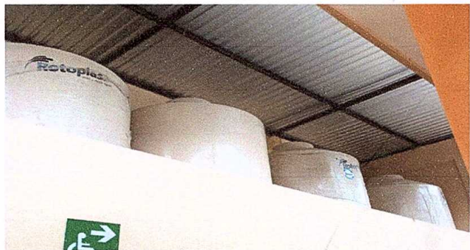
Foto7: Sustrucion de deposito de agua 2500 lt
