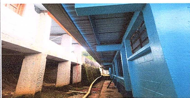
Foto 5: Canales y bajadas de agua pluvial en mal estado
