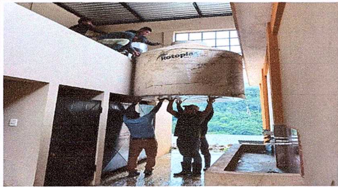
Foto7: Sustitucion de deposito de agua 2500 lt
