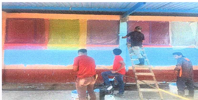
Foto 6: Pintura en muros exteriores e inferiores
