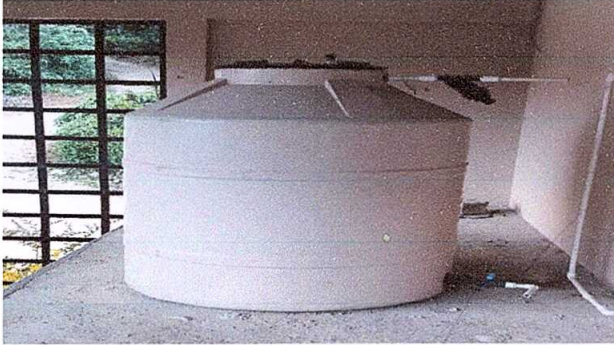
Foto7: Sustitucion de deposito de agua 2500 lt
