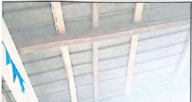
Foto 2: SUSTITUCIÓN DE SOPORTE ESTRUCTURAL DE SOPORTE DE MADERA, POR METAL
