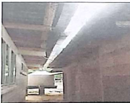
Foto 3: SUSTITUCIÓN DE CANAL DE METAL
