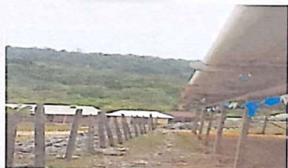
Foto 4: MEJORAMIENTO DE BAJADA DE AGUA PLUVIAL TUBO DE PLÁSTICO PVC DE 4 PULGADAS
