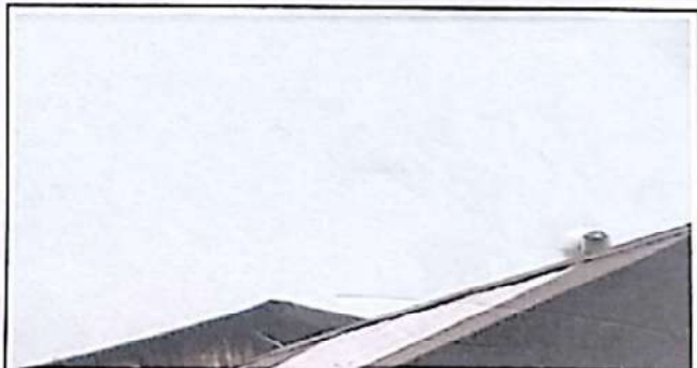
Foto 6: SUSTITUCIÓN DE CAPOTE DE LÁMINA TROQUELADA
