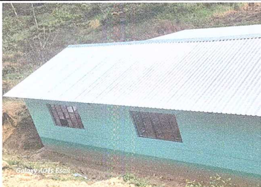
Foto1: cubierta de lámina, estructura de techo
