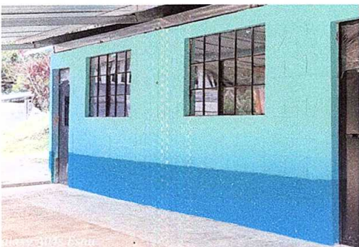
Foto 5: pintura en muros exteriores
