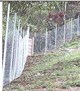
Foto 2: Circulación tubo y malla
