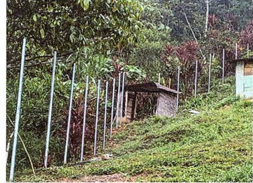
Foto 2: Circulación tubo y malla
