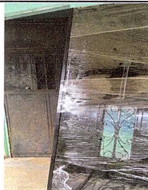
Foto 2: sustitución de puertas de metal
