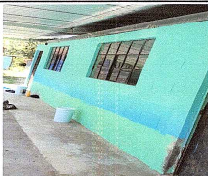
Foto 5: pintura en muros exteriores
