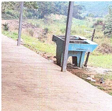
foto 3: Pilas plásticas de 2 lavaderos
