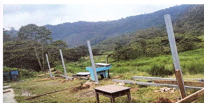
Foto 6: losa de patio
