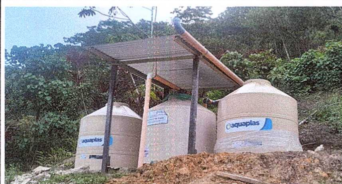
foto 3: reparación y mantenimiento de cisternas/ depósitos de agua
