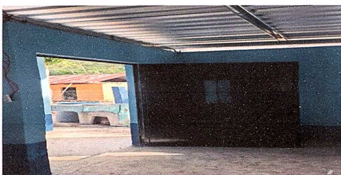
Foto 3: sustitución de puerta de metal
