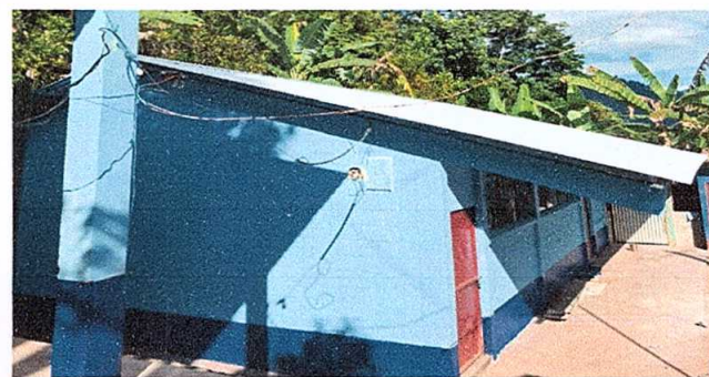
Foto 6: pintura en muros interiores y exteriores
