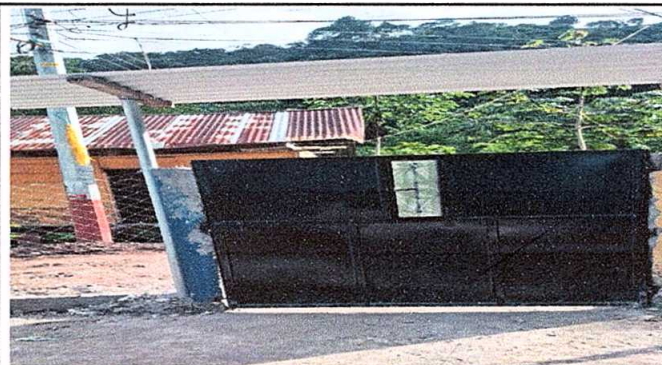
Foto 4: sustitución de porton de metal
