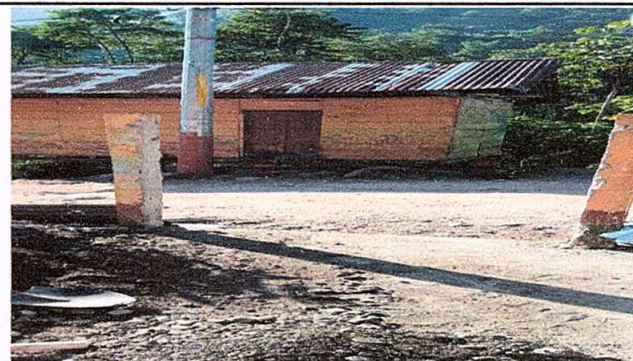
Foto 4: sustitución de porton de metal
