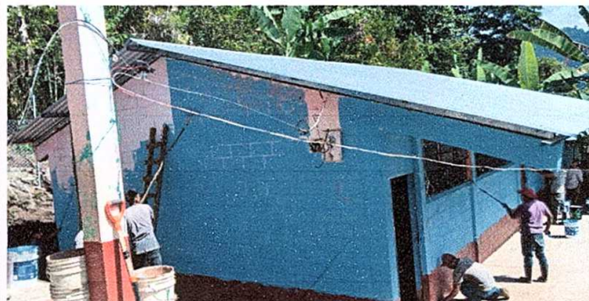
Foto 6: pintura en muros interiores y exteriores
