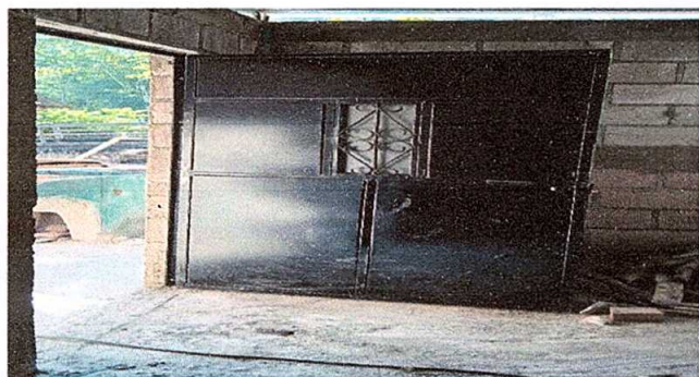
Foto 3: sustitución de puerta de metal
