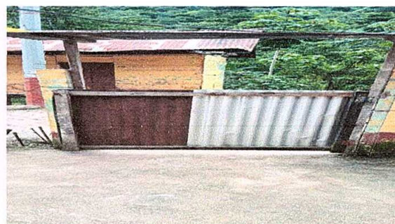
Foto 4: sustitución de porton de metal
