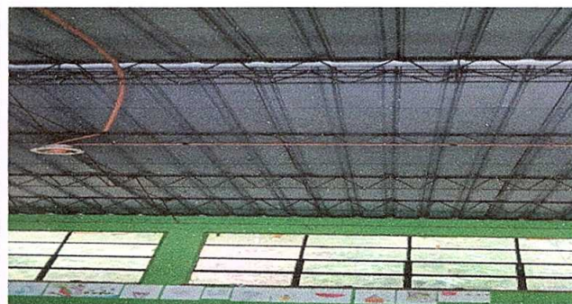
Foto 2: sustucion de estructura de soporte de metal, por metal
