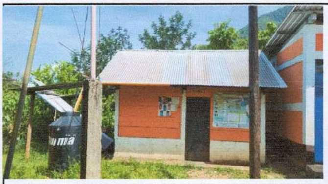
Foto 10: SUSTITUCIÓN DE TINACO DE 500 LITROS POR TINACO DE 2500 LITROS
