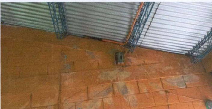
Foto 3: INSTALACIÓN DE TUBOS DE 2X3 RECTANGULAR PARA LA ESTRUCTURA DE LA ESCUELA
