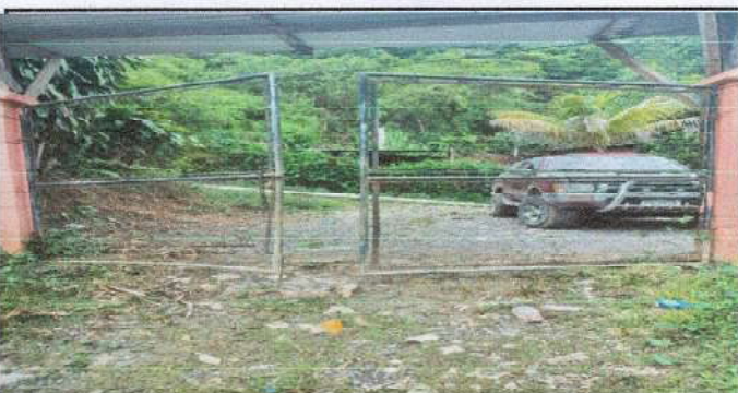
Foto 5: SUSTITUCIÓN DE PORTON DE METAL POR PORTON DE MALLA
