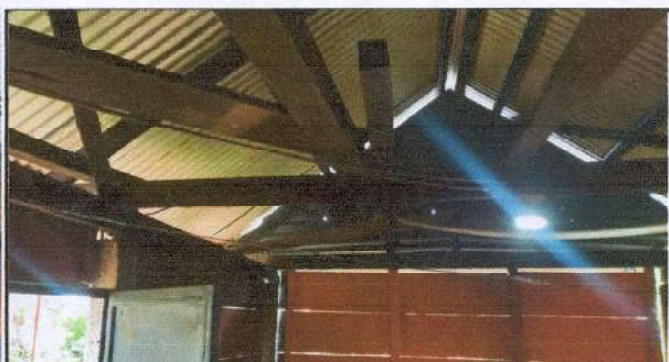
Foto 4: INSTALACION DE COSTANERAS DE 2X3 PARA LA ESTRUCTURA DE LA COCINA
