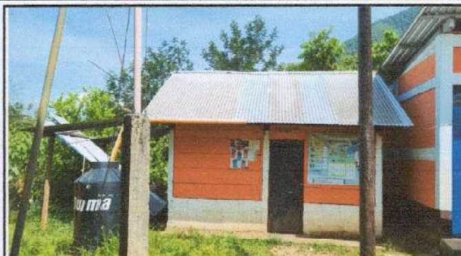
Foto 2: INSTALACION DE LAMINAS TROQUELADAS DE LA COCINA
