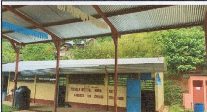
Foto 1: INSTALACION DE LAMINAS TROQUELADAS DE LA ESCUELA
