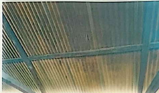
Foto 2: Sustitución de estructuras de soporte
