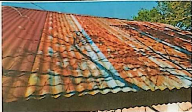
Foto 1: Sustitución de lámina
