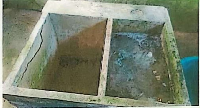
Foto 8: Mejoramiento de pila
