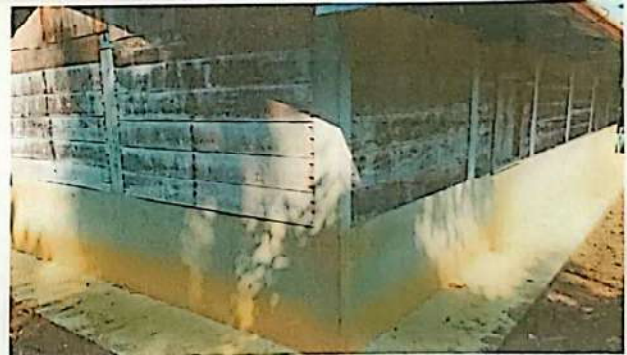
Foto 10: Pintura en muros exteriores e interiores
