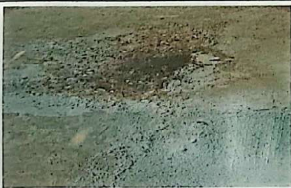
Foto 5: Reparación de piso
