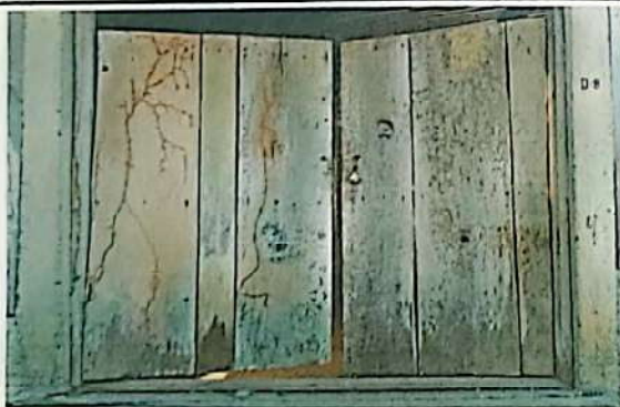
Foto 3: Sustitución de puerta de madera por metal
