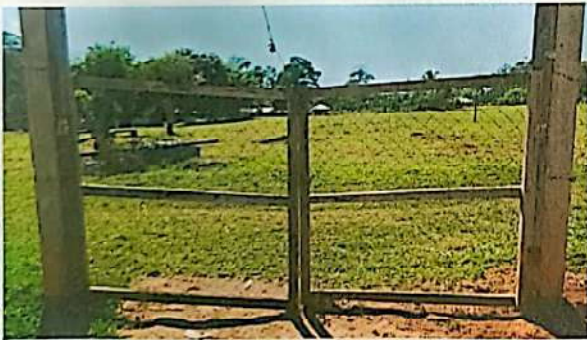
Foto 9: mejoramiento de porton
