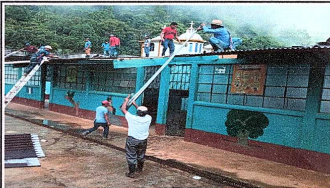
COLOCACION DE SOPORTES
