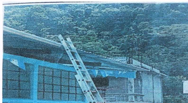
Foto 4: COLOCACION DE CANALES
