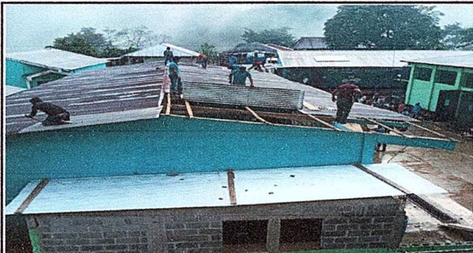
Foto1: ELIMINACION DE LAMINA
