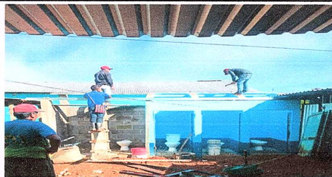
Foto 6: REMODELACION DE SANITARIOS
