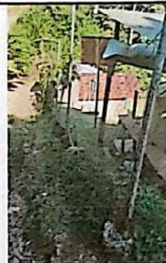
Foto 6.1: Reparación de muro perimetral con tubo hg y malla galvanizada
