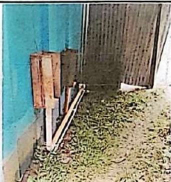
Foto 5.2: Sustitución de mingitorios
