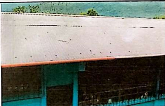
9.1: Sustitución de canal de pvc
