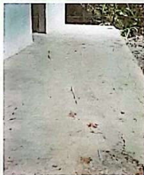
Foto 3.1: Sustrucción de piso de concreto por piso de granito
