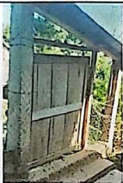
Foto 1.1: Sustrucción de portón de ingreso
