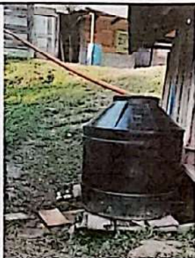
Foto 7.1: Sustitución de depósito de agua de 2750 litros
